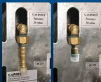
30 mbar Anschluss    50 mbar Anschluss
