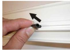
Glaskuppel mit Hilfe der Kurbel komplett öffnen. Profildichtung aus der Nut entfernen. Profildichtung ist an allen Ecken (Radien) sowie am Stoß mit Sekundenkleber fixiert. Nut mit Hilfe eines Klingmessers bzw. kleiner Schraubendreher von
