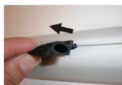
Scheibe herausnehmen. Profildichtung aus der Nut entfernen. Profildichtung ist an allen Ecken (Radien) sowie am Stoß mit Sekundenkleber fixiert. Nut mit Hilfe eines Klammernmessers bzw. kleiner Schraubendreher von Klebe und Gummiresten säubern. Neue Dichtung einbringen und verkleben anschließend in umgekehrter Reihenfolge Glaskuppel wieder montieren.
